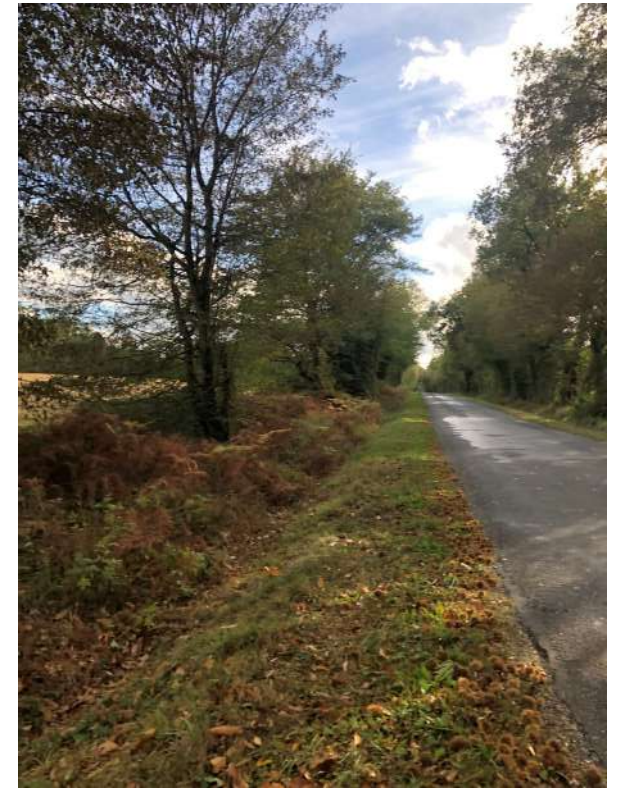
Etat de la végétation le long de la départementale
